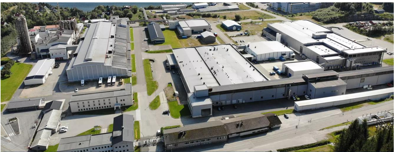
Figur 5-17. Glomfjord Industripark i dag. «Sinken» og administrasjonsbygget til venstre i bildet.
