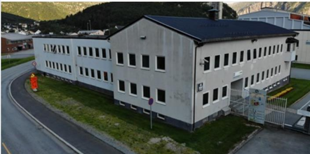
Figur 5-18. Administrasjonsbygget. Kilde: Glomfjord Industripark.
