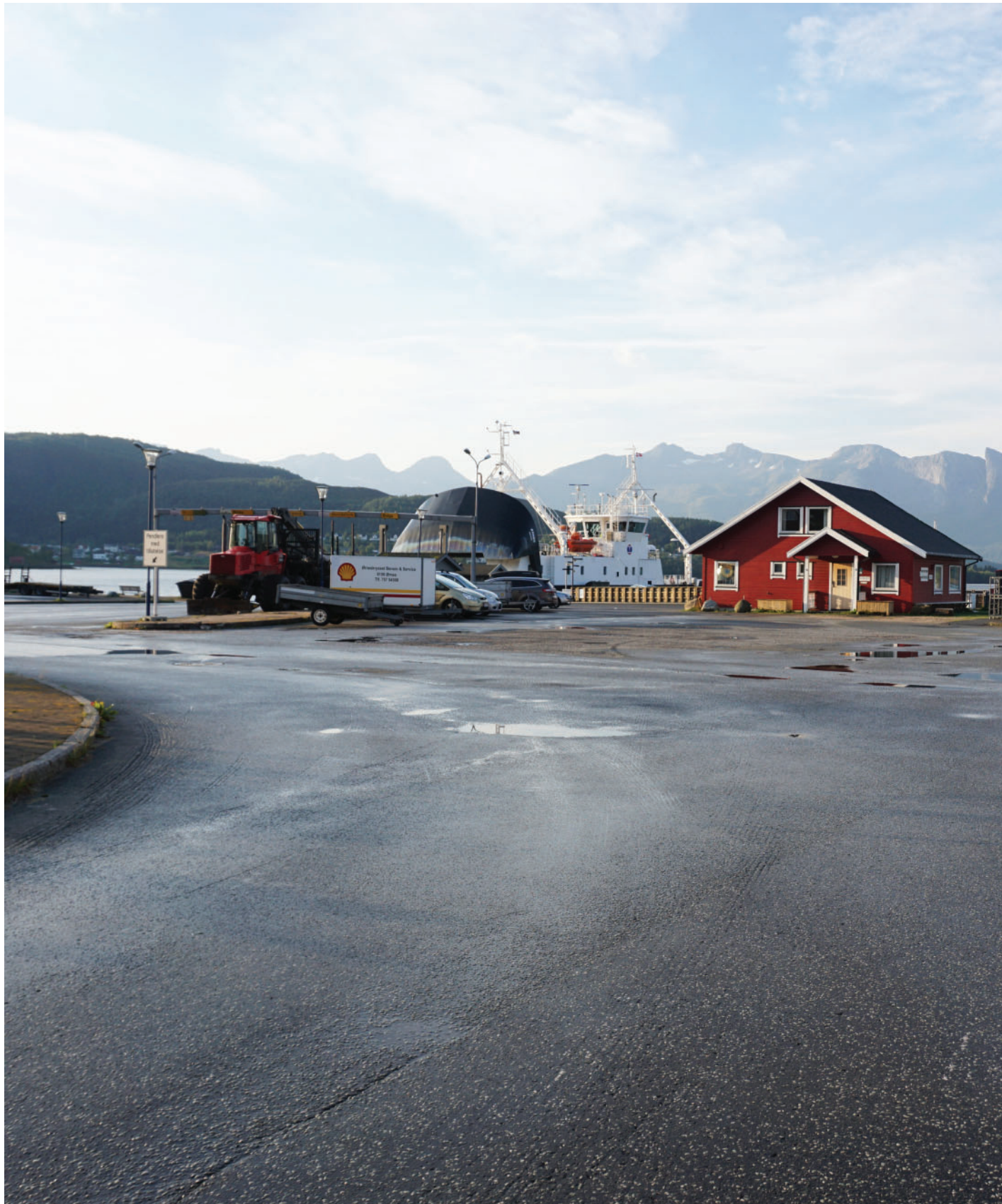
««« Dagens situasjon på Neset. Store udefinerte asfaltflater gjør det utrygt å ferdes som fotgjenger. Trafikksituasjonen preges av mye overflateparkering.
