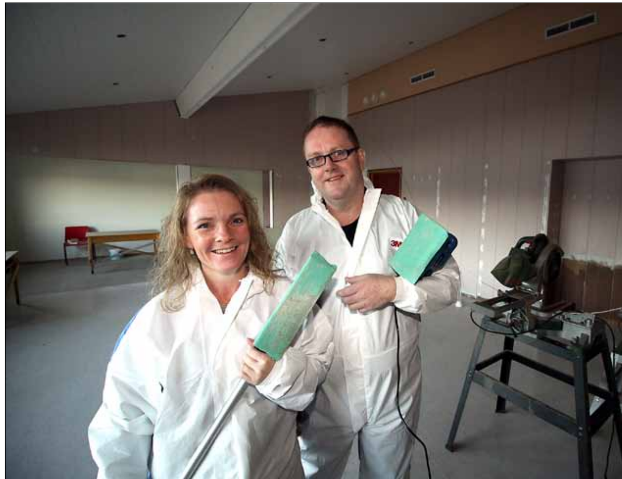
Kjøpet av Åg skole gir Elin og Trygve Danielsen mulighet til å realisere sin kultursenter-drøm. Men også et utall av arbeidstimer med oppussing i bygget. Her i de kommende kafélokalene.
