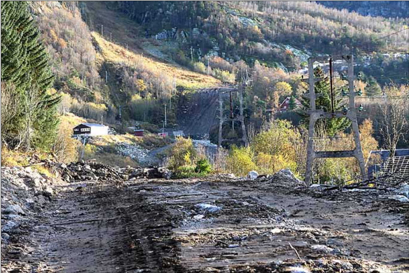
Den nesten to kilometer lange traséen i bratt og ulendt terreng har gitt utfordringer for både Yara og Bernhardsen Entreprenør. Nå er prosjektet snart fullført, og med bare en liten overskridelse.
