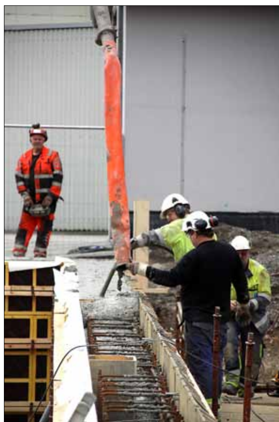
Bygget er 200 kvadratmeter stort, og veggene 30 centimeter tykke. Ventilhuset er en solid byggejobb for Knut Bergheim (f.v.), Roar Nygård og Tony Lorentzen.
