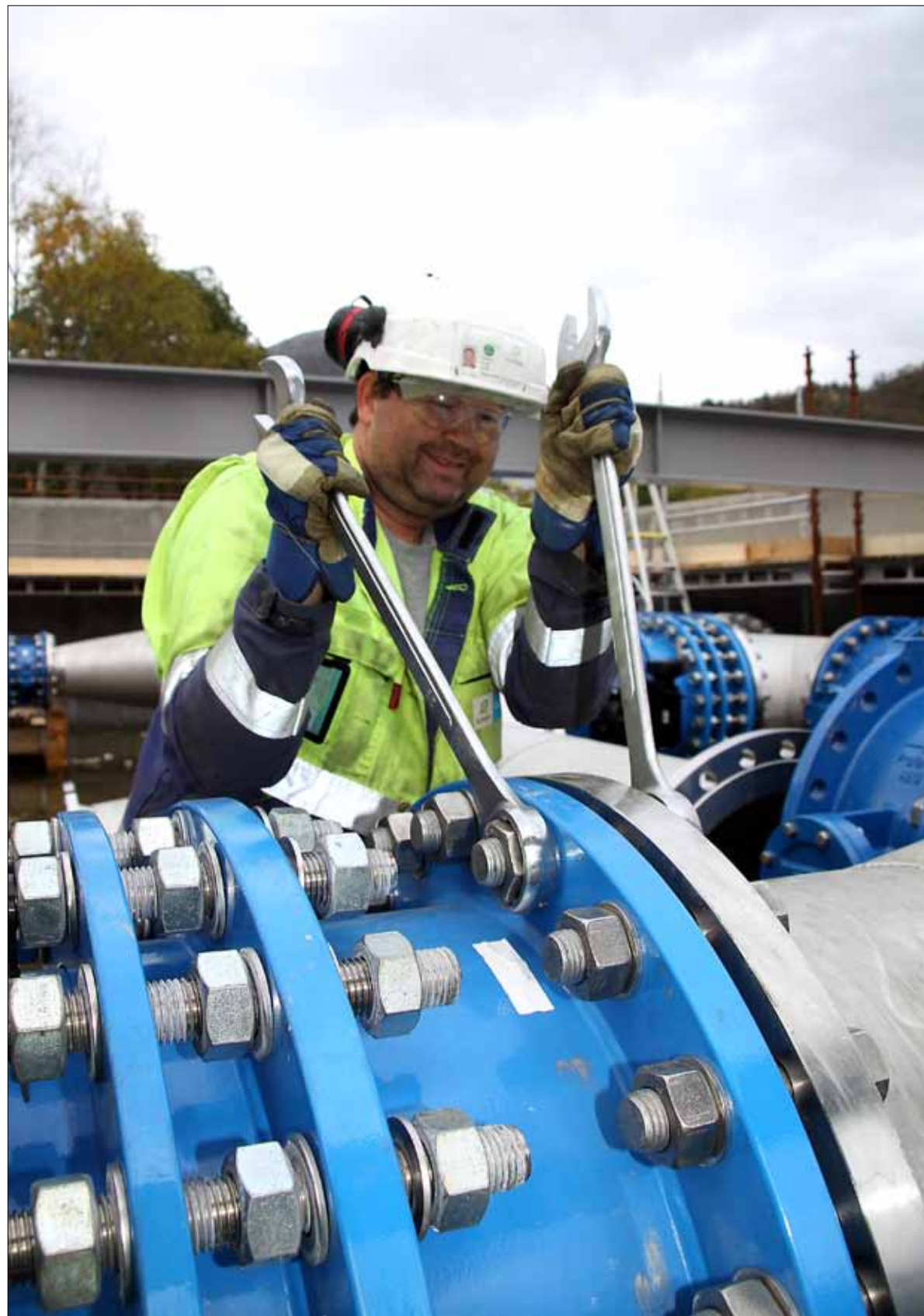
- Det er sjelden kost å jobbe med så grovt verktøy! smiler Virgil Anbakk. Med fastnøkler på 70 millimeter i hånden har han vært sentral i Bilfingers monteringsjobb i det nye ventilhuset til Yara Glomfjord. Noen av boltene veide 4,2 kilo!
