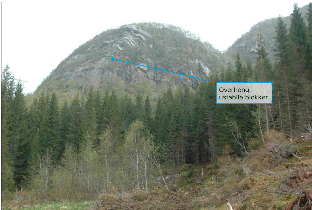
Bilde 11: Nedre Valla, overhengende og ustabile blokker, mot nord.
