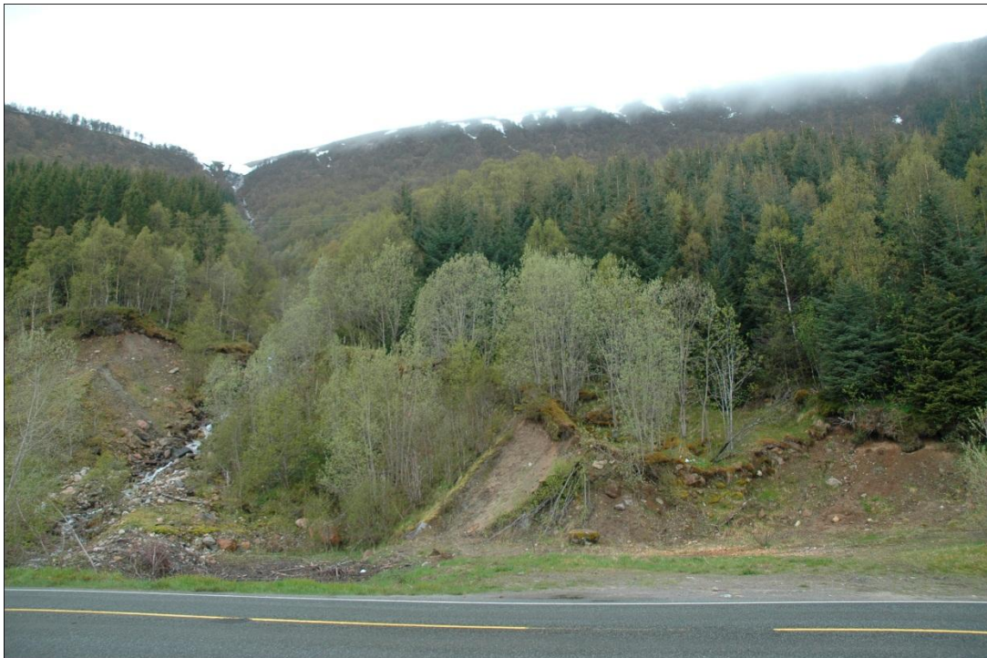
Bilde 7 Skråning i løsmasser ovenfor kaiområdet
