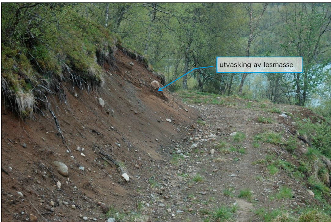
Bilde 9: Skjæring langs bruksveien i skogen, som viser tegn på erosjon som utvasking av stein og grusmateriale
