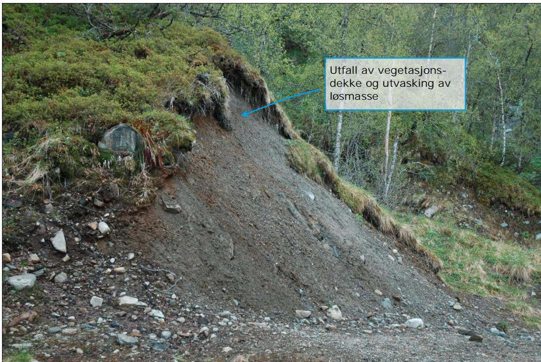
Bilde 8: Skråning langs bruksveien i skogen, som viser tegn på erosjon som utvasket vegetasjon
