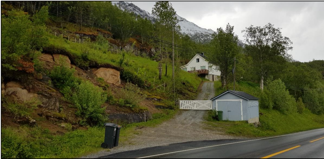
Figur 35: Eksempel på en lokal skrent lengst øst i området, med bergsprekker som avløser bergblokker.
