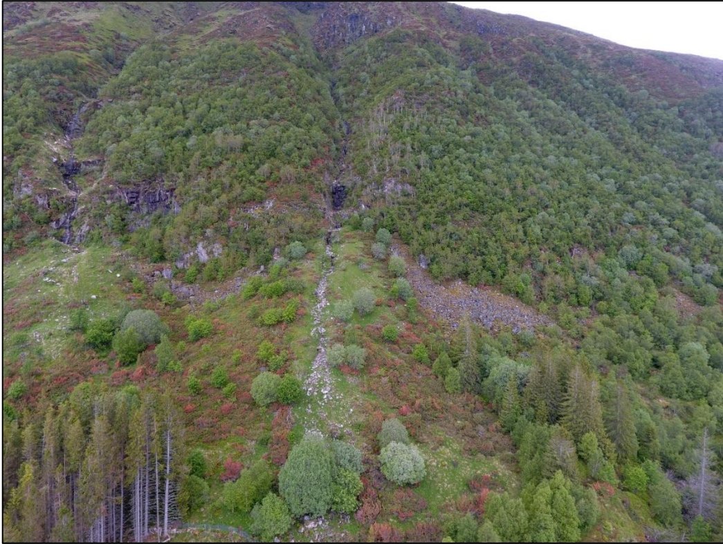
Figur 19: En skredvifte med spor etter snøskred, flomskred og steinsprang den østlige delen av området.
