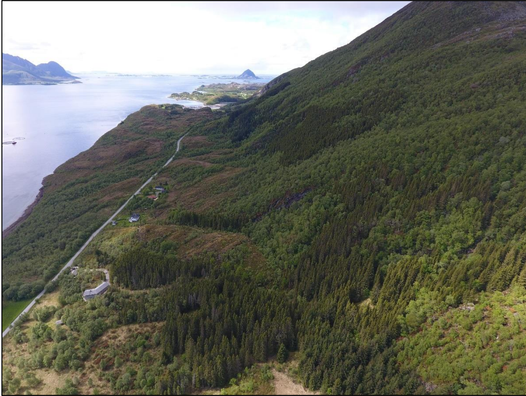
Figur 25: Terrenget i nedre del av skråningen preges av mye berg i dagen og lite løsmasser og blokk.
