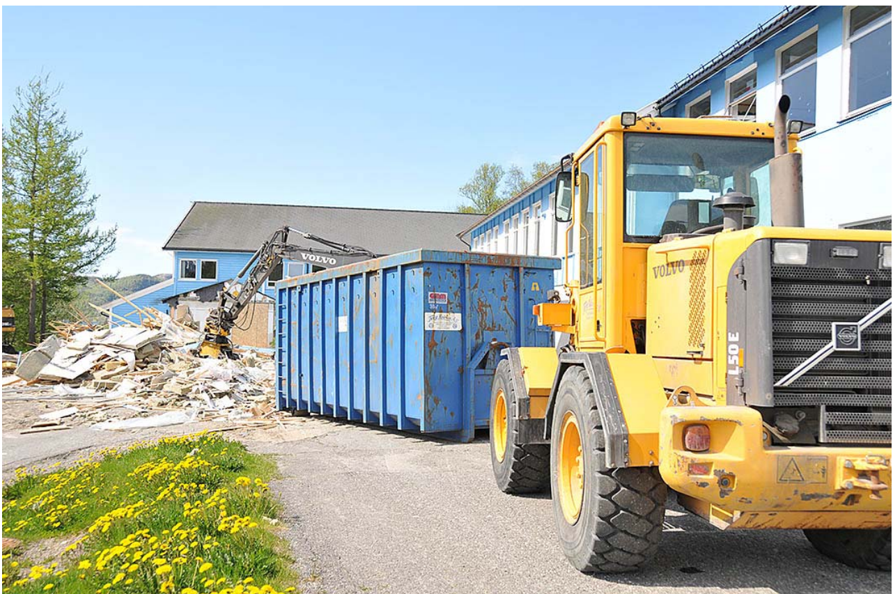
I juni 2017 startet arbeidet med ombyggingen av Spildra skole. Her blir deler av den gamle skolebygningen revet. Foto: Connie Slettan Olsen.
