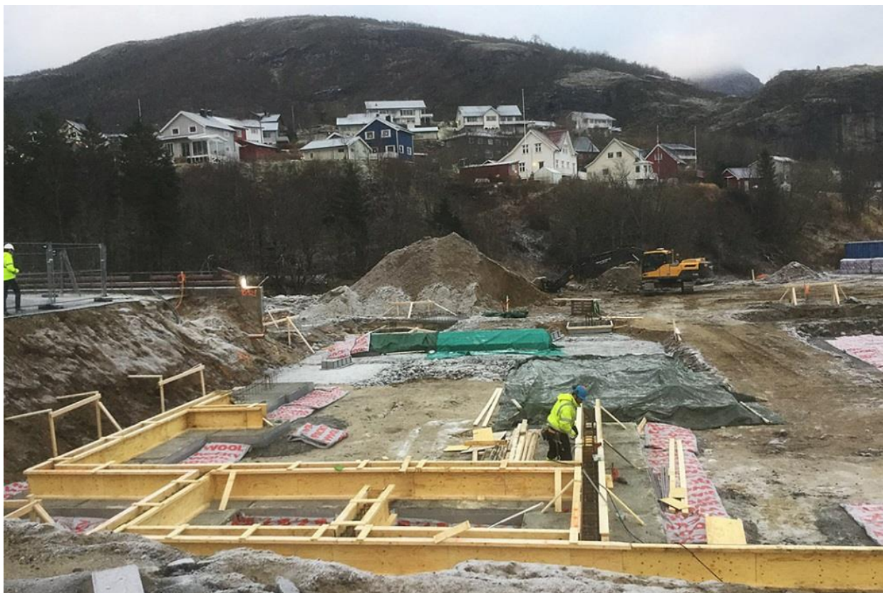
Grunnarbeid ved Meløy helse- og velferdssenter desember 2018. Foto: Ragnar Drevvatne.
