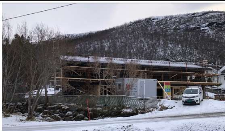
Ny bolig under oppføring, Åsveien 20
