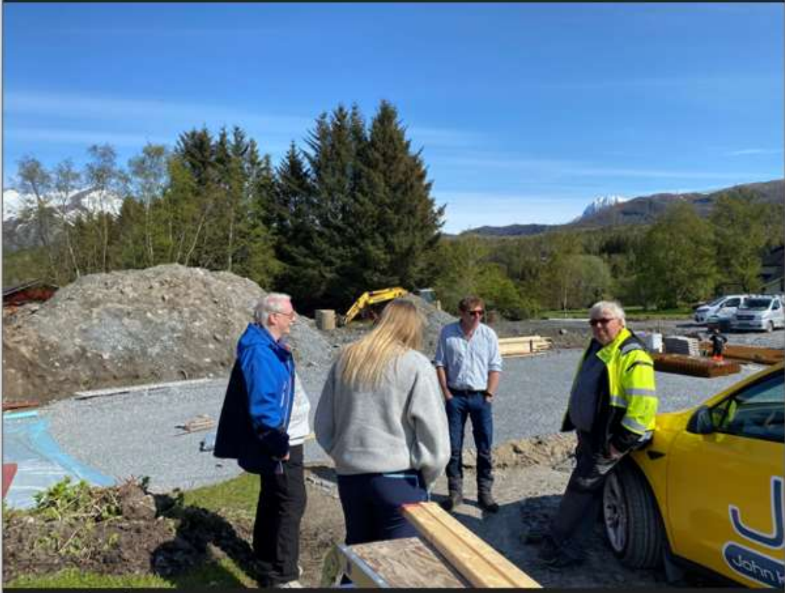
Bygging av fjør Halsos.
