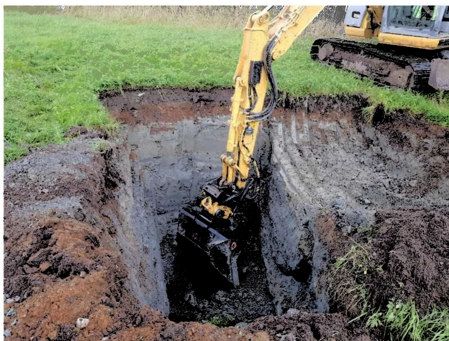
Figur 3: P01. Stoppet i fast leire, bilde viser endelig gravet dybde.
