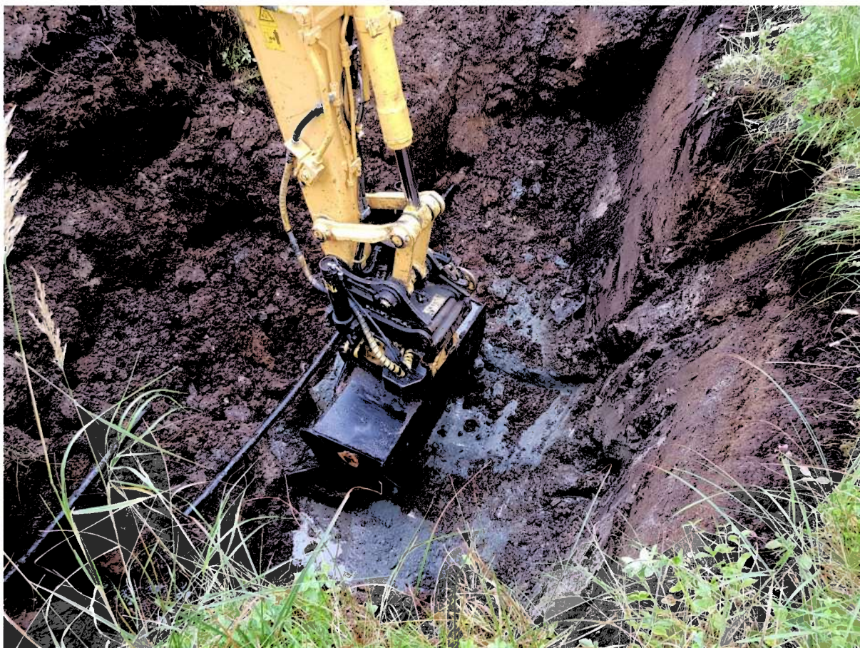
Figur 6: P02 Stoppet graving i fast leire. Vann i bilde fra avgravet ledning.
