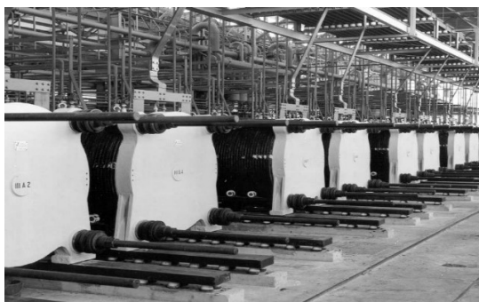
Produksjon av hydrogen gass. Det gamle elektrolyseanlegget i Glomfjord. Nedlagt i 1993. Var i drift i 44 år.
