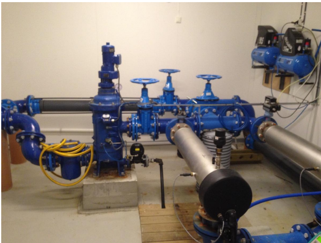
Bilde 4-6 , viser UV anlegget i Halså vannverk.
