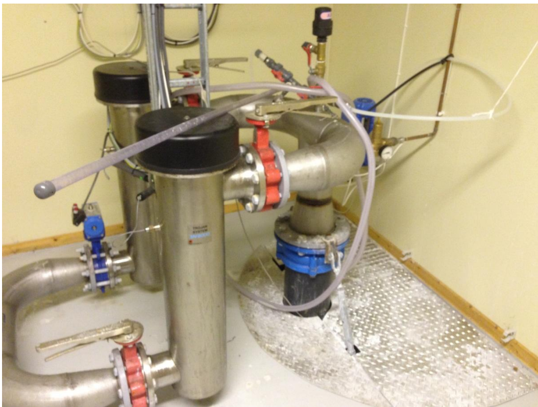
Bilde 4-7 , viser UV-anlegget i Vassdal vannverk.
