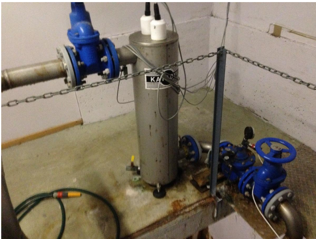
Bilde 4-5, viser UV-anlegget slik det var i Bjerkli.
