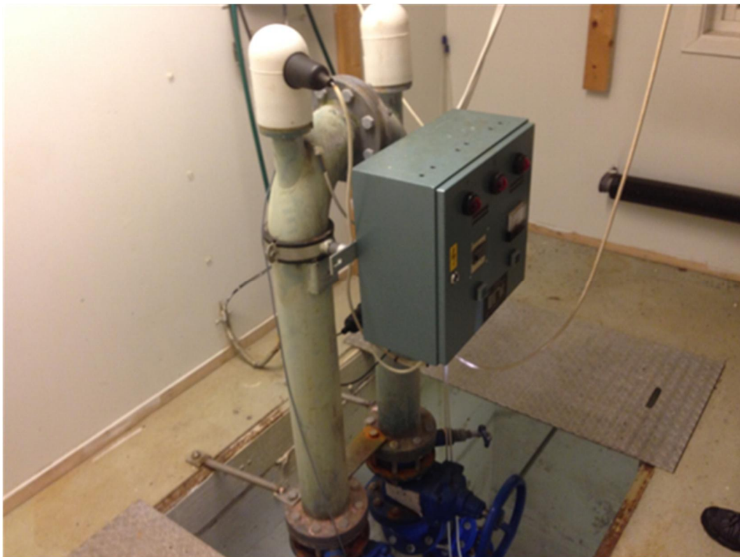
Bilde 4-4 , viser UV-anlegget i Vassaksla
